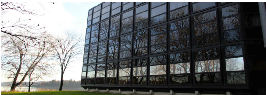
Figur 46 Fasade på Kjørbo (Powerhouse 2012)
