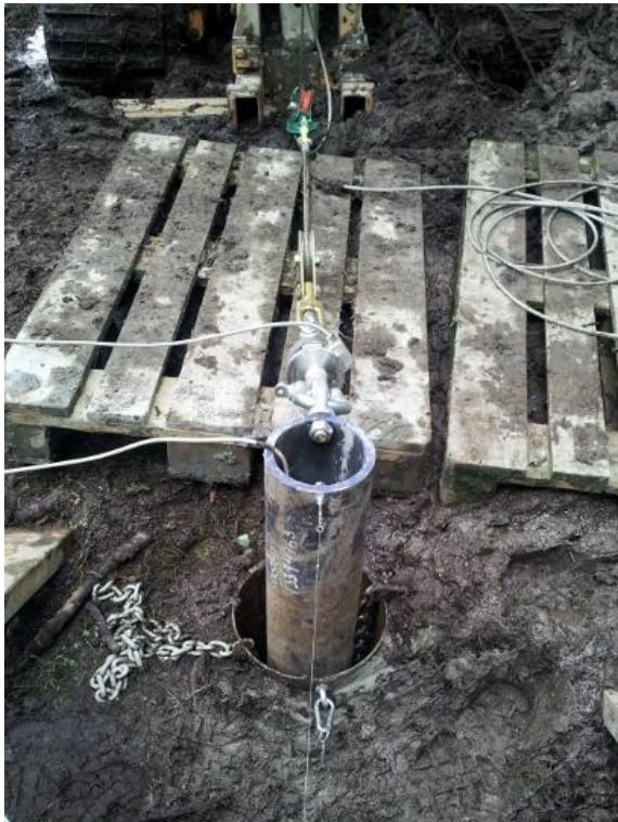
Figur J 4 Ferdig rigget Forsøk 2
