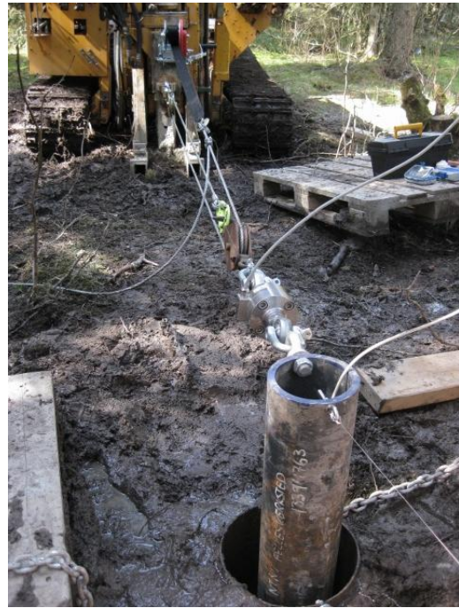
Figur J 2 Ferdig rigget Forsøk 1
