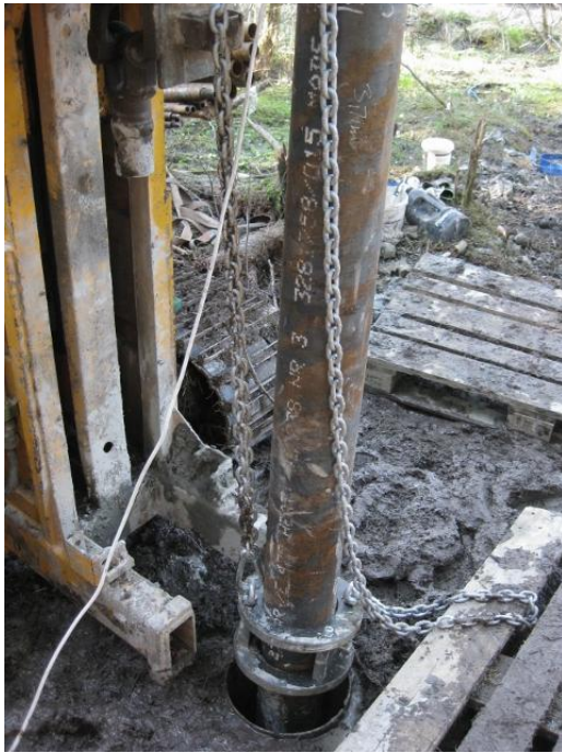
Figur J 1 Installasjon av testrør
