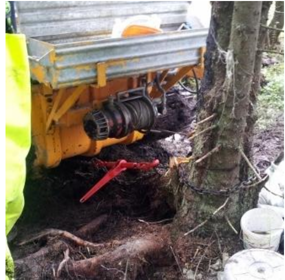
Figur J 5 Forankring av boreriggen i bakkant
