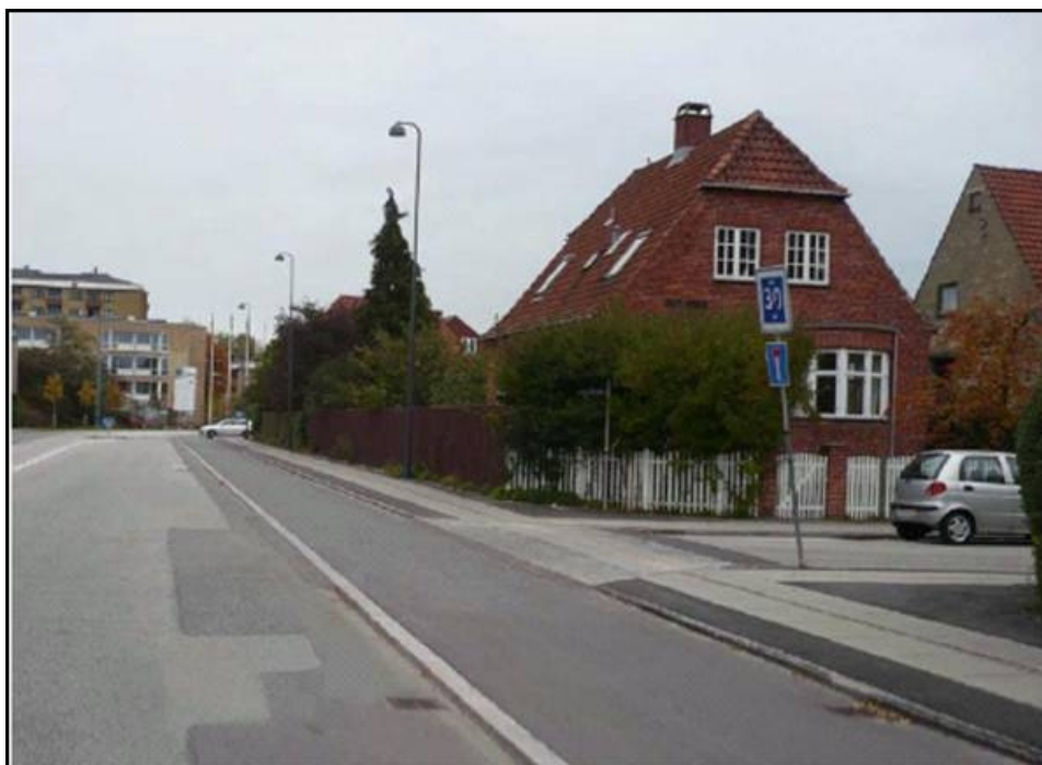
Figur 4.1: Adskilt sykkelsti og fortau. Opphevet avkjørsel behøver ikke skilt og oppmerking (Vejdirektoratet 2010).
