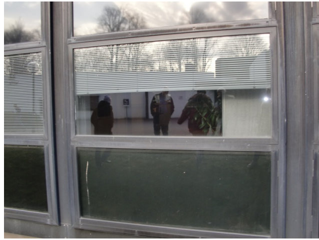
Figur 45 Fasade. Fargen på aluminiumsprofilane og rammene er litt falma
