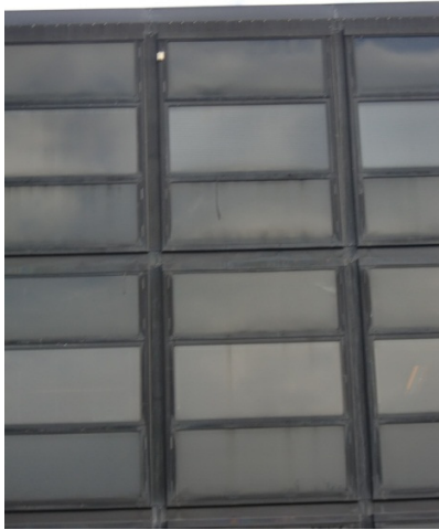
Figur 45 Fasade. Fargen på aluminiumsprofilane og rammene er litt falma
