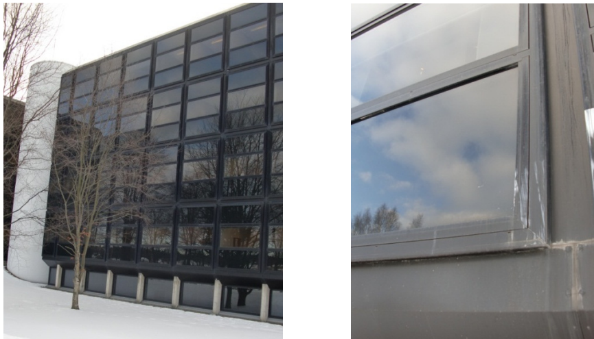
Figur 40 Vindauga og fasadekledning
