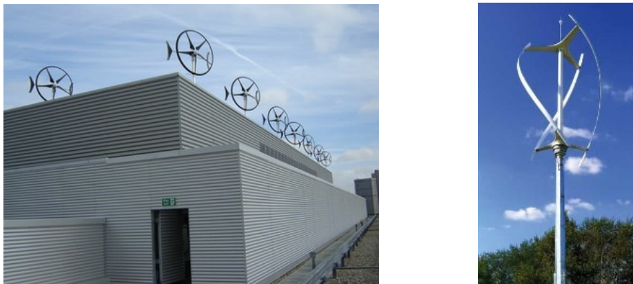
Figur 29 Horisontalakslande vindturbinar på tak til venstre og ein vertikalaksla vindturbin til høgre (ZERO, 2010b)
