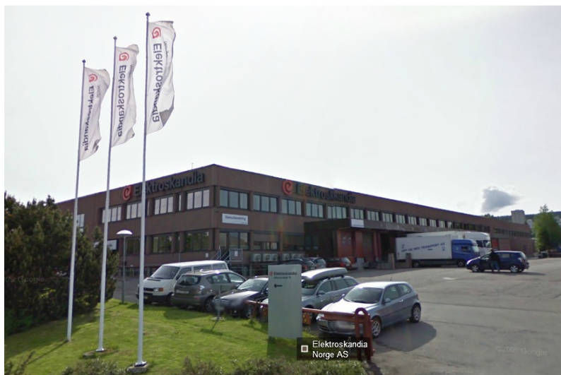
Figur 27: Alfasetveien 11 hentet fra Google Maps
