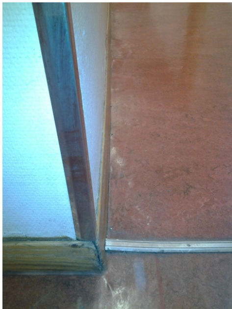
Figur 39: Bulende linoleum i gangen i kjelleren
