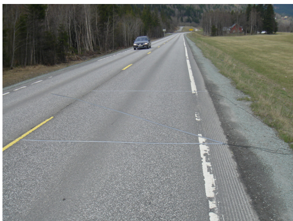
Fig. 61. RR1/RR2: E6 Støren – Soknedal.
