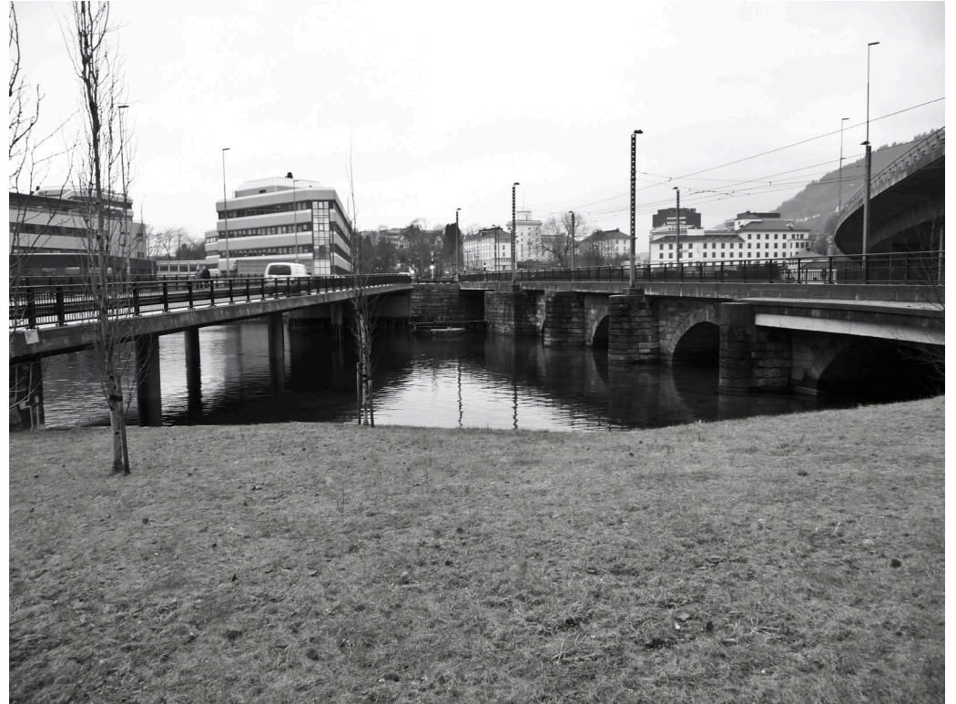
Rommet mellom de to laveste broene (Nye Nygårdsbro II til venstre, deretter Gamle Nygårdsbro, og øverst til høyre er Nye Nygårdsbro I)
