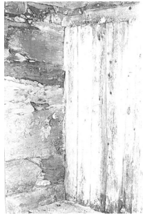
Kjellervegg i Kjøpmannsgata 37. 16
