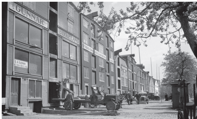
Motivet viser brygger i Fjordgata i 1934. En kan se at flere av bryggene er påbygget to etasjer. Kilde: www.digitaltmuseum.no
