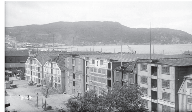
Bildet viser bryggerekken i Fjordgata mot Fjordgata fra 1947. Fjordgata 80 er bryggen som ligger som brygge nr. 2 fra venstre. 46
