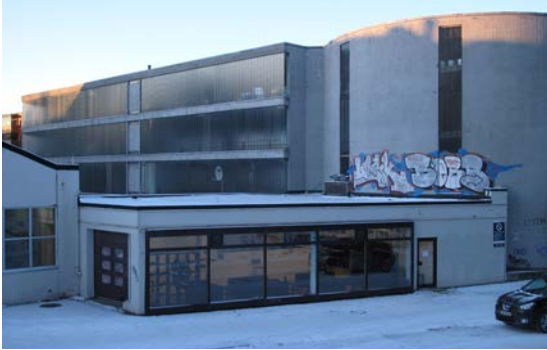
Fasaden til mellombygningen med det utstikkende glasspartiet.
