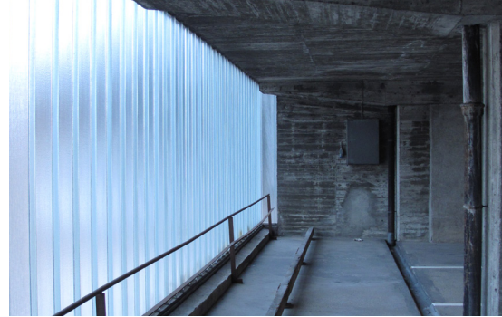
Profilttglassene er montert på en støpt betongsokkel og satt med en distanse av 1 cm fra hverandre.
