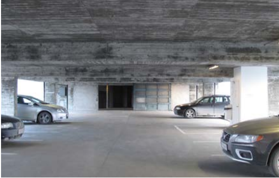
Fjerde og femte etasjen i parkeringshuset er ikke malte.
