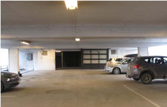
Andre og tredje etasjen i parkeringshuset er hvitmalt. Tredje til femte etasjen har store skyveporter, andre etasje har mer moderne løfteporter.
