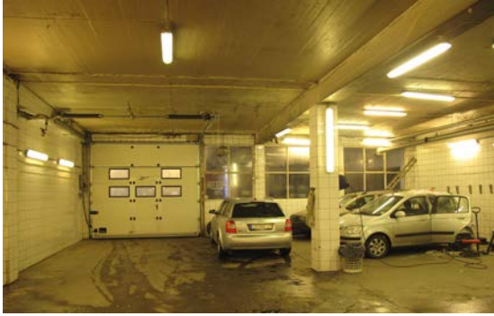
Deler av verkstedhallens første etasje er helt kledd i flis.
