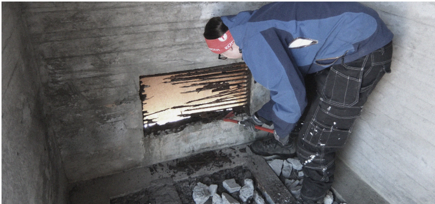
Rustne delar må vekk, og oljegropene vert fylt med betong frå revet vegg.
