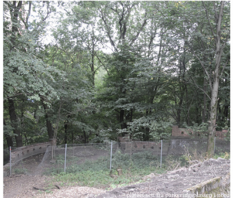
plattaet sett fra parkeringsplassen i nord
