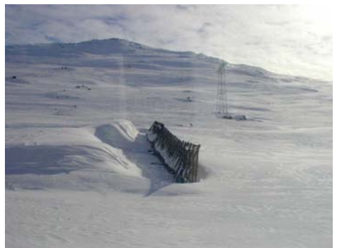
Vindskjerm uten vegg bak danner turbulens på og snøansamlinger på le side. Denne effekten vil danne en gangsoene langs den lengste vindskjermen i anlegget.
