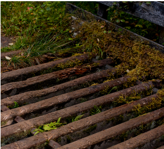
23: Ferist av det gamle slaget på vegen mellom Korntrøa og Grytlykkja.
