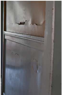
Typiske tapetskader
