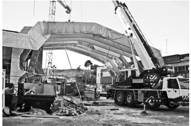
1/12-2010. De første prefabrikerte limtrebjelkene heises på plass. Disse vil bære taket over foajéen.
