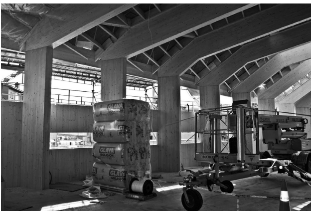
24/3-2011. Interiørarbeidet begynner med isolering av taket.
