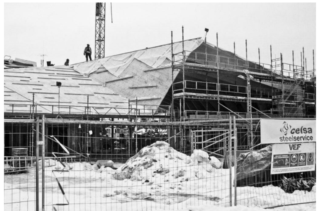
21/1-2011. Taket over hovedinggangen monteres. Prefabrikerte massivtreelementer.
