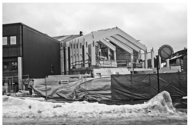
2/2-2011. Konstruksjonssystemet fortsetter mot "baksiden" av bygget.
