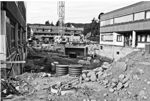
31/8-2010. Tomta mellom voksenopplæringa og kinoen kraves ut helt inntil eksisterende kjeller.
