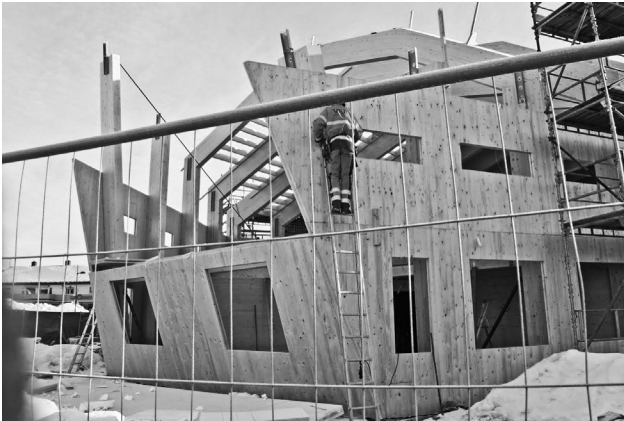
9/3-2011. Ribbene kles av prefabrikerte massivtreelementer med ferdig utskjærte vindusåpninger.
