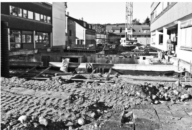
21/9-2010. Kjelleren støpes, og det etableres gjennomgangsmuligheter til begge nabobygg.
