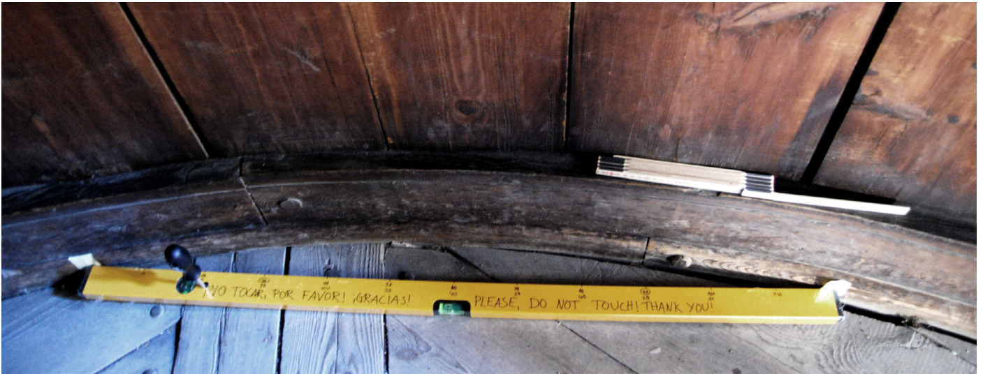
Manuell oppmåling i apsis, Gol stavkyrkje, med bruk av vater som referanseakse.
