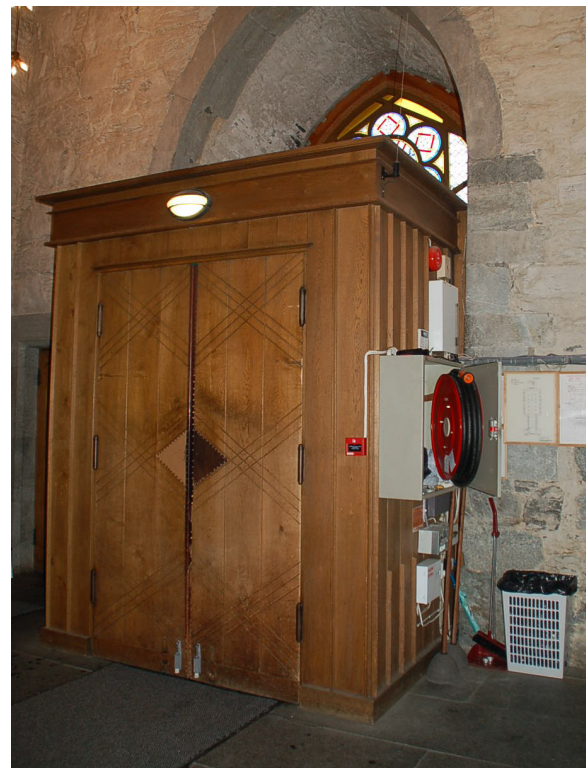
Eyvind Moestues indre vindfang fra ca 1940 i forhallen. Bak og over "sluseboksen" ses overlyset til von der Lippes dør fra 1860-tallet, som ble satt tilbake i vestportalen i 1983.
