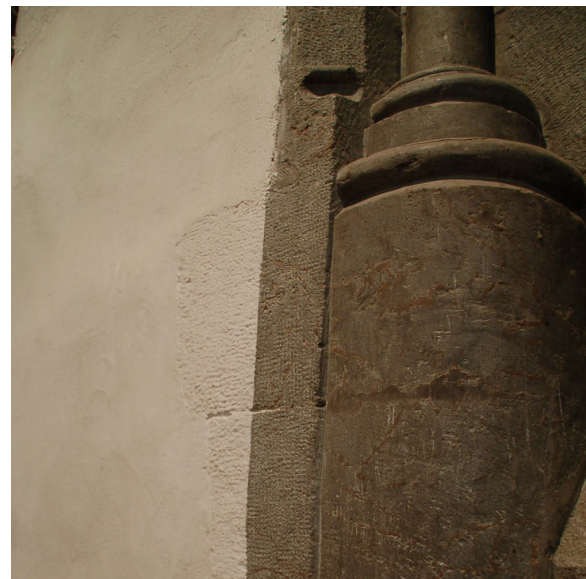
Over: Detalj der korets kalkede vegg møter kvaderstein i vindusomramning.
