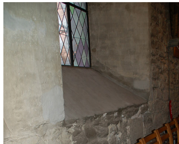
Under: Tilsvarende i søndre sideskip, der Moestue og Fischers sementslemming fortsatt finnes.
