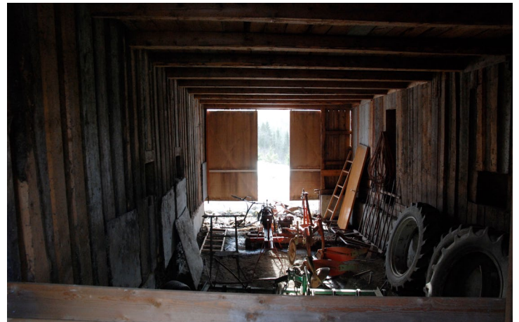
Utstyrslaget, sett fra nordsiden
