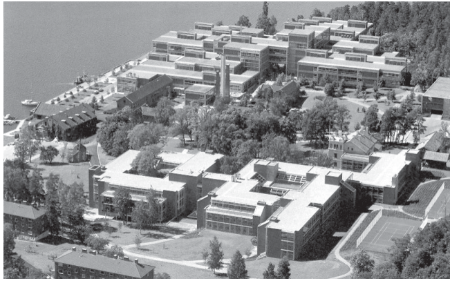
Figure 53. Norske Veritas, Høvik, 1976, architects Lund & Slaatto.
