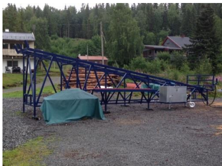
Bilde 1: Tømmer rampe
