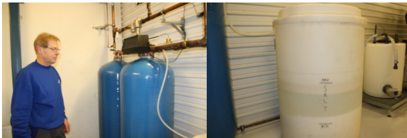
Bilde 22. Kaldt vann fra nettet kommer inn på to filter, salt tilsettes for å få de senere prosesser i gang, blant annet gjøre vannet mindre hardt.
