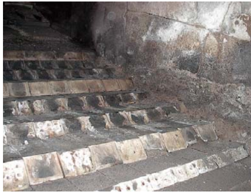
Bilde 37 og 38. Fra første stopp på ristanlegget pga forurensninger i brenselet.
