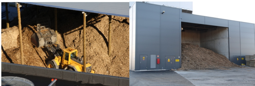
Bilde 3 og 4. Ferdig knust flis til flislager og dagsilo til fyren
