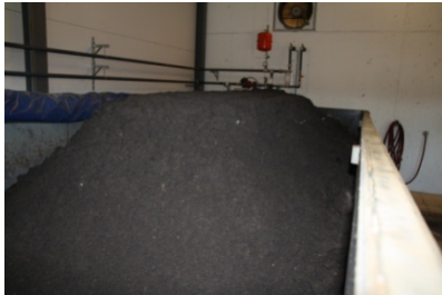
Bilde 17. Askecontainer som venter på opplasting til Langøya deponi for farlig avfall. Den står her en stund for avrenning av vann.(deponivann, det også- går til spillvanntank)
