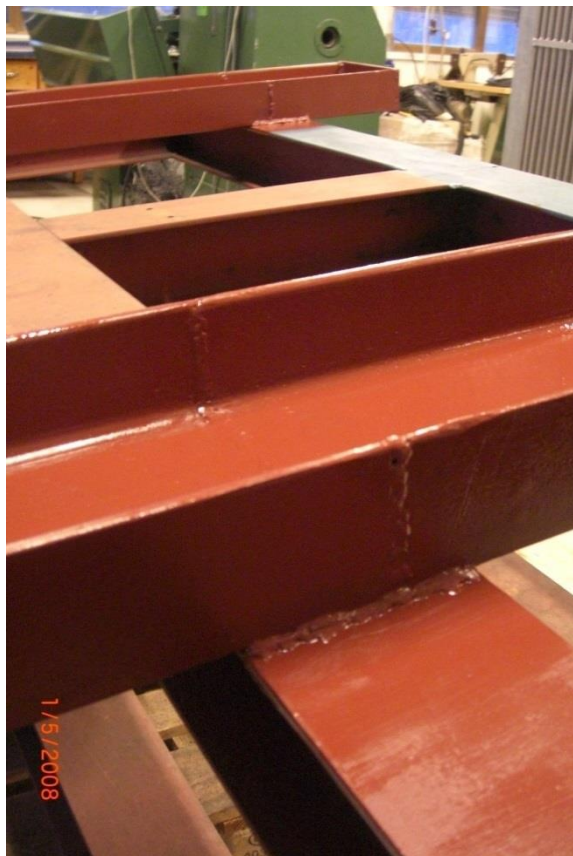
U-profiler sveiset og skjøt i rammen
