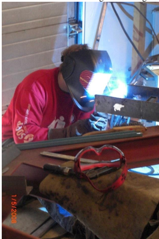
Sveising av armeringsstål – festeanordning for kjørebru på U-profil
