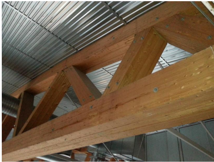
Figur 16: Dybelforbindelse i fagverkskonstruksjon, foto: Lars Vidar Leikåsen
