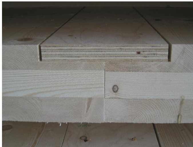
Figur 26 Sammenføyning som er synlig fra oversiden (19)
