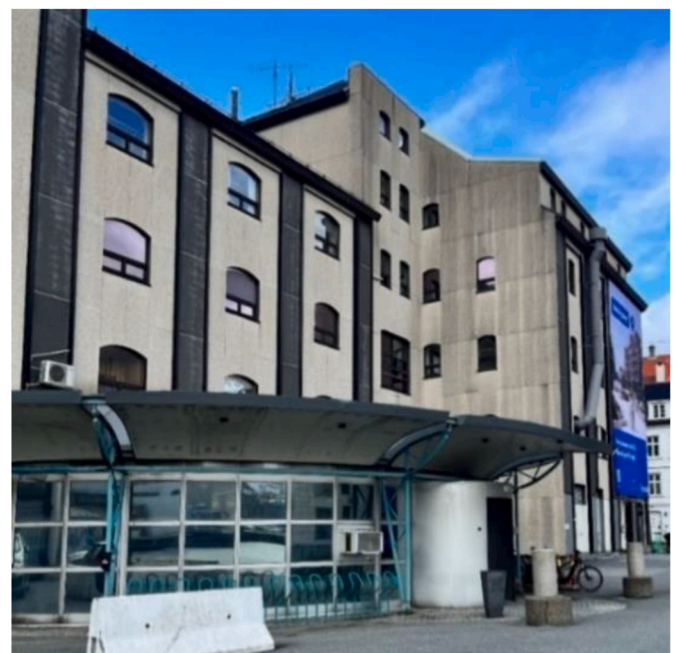
Fig. 2. The existing building in Nøstebukten Brygge, Bergen.
