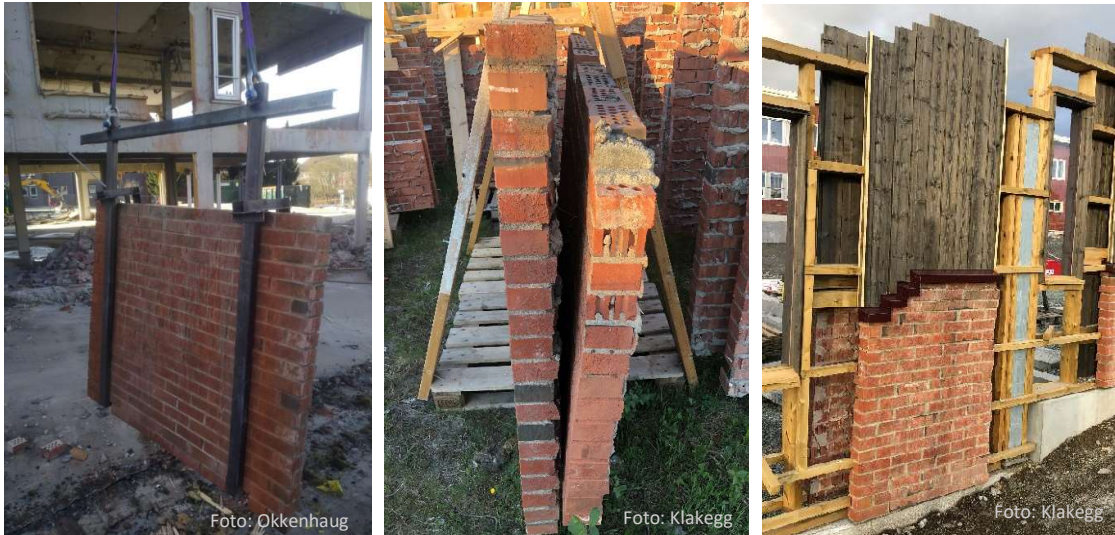
Figur 46 Gjenbruk av mursteinspaneler i støyvegg – et veldig synlig miljøtiltak
