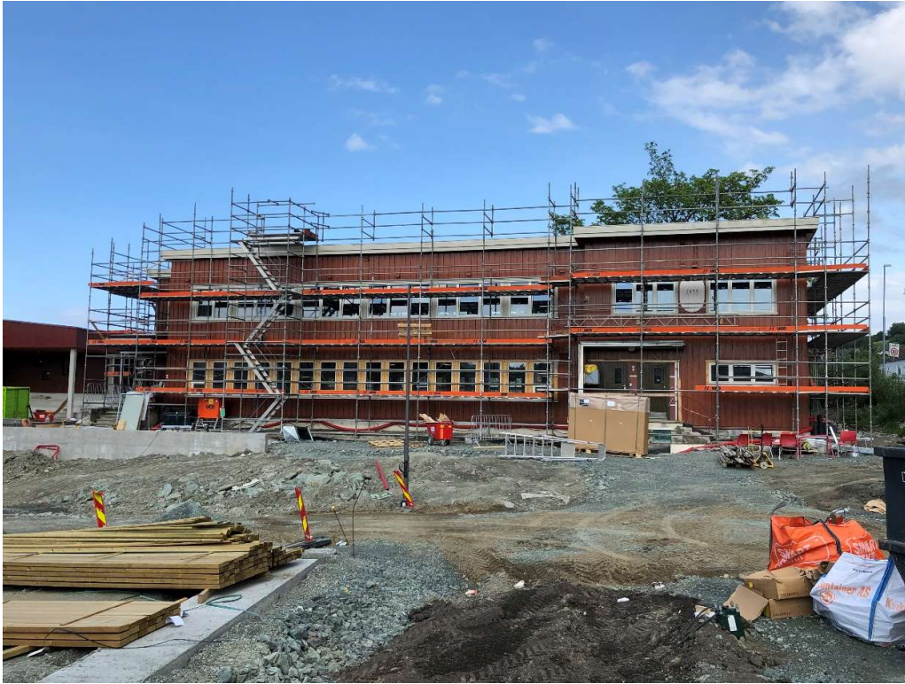
Figur 5 Rehabilitering av den gamle bygningen ved Nidarvoll skole i juni 2023 (Foto: Klakegg)
