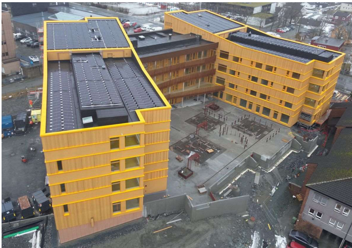
Figur 17 Rehabiliteringssenteret slik det sto ferdig våren 2023 (Meland, 2023).
