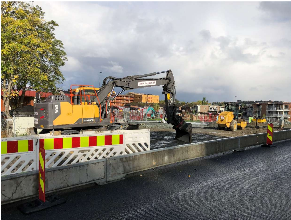
Figur 6 Pågående arbeider i Klæbuveien ved skolene på Nidarvoll i oktober 2023. (Foto: Klakegg)
