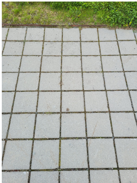
Figur 4.2 Selv om belegningssteinen er spesialutviklet for å la overvann sive ned i fordrøyingslaget under ser den helt normal ut.
