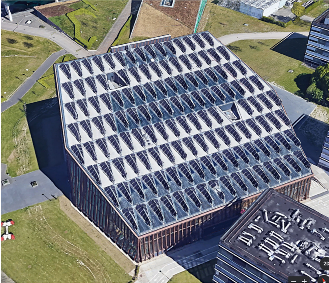
Figur V1.1 Energy Academy Building på campus til Groningen Universitet (skjermdump fra Google Earth av Nijenborgh 6, 9747 AG Groningen, Nederland).
