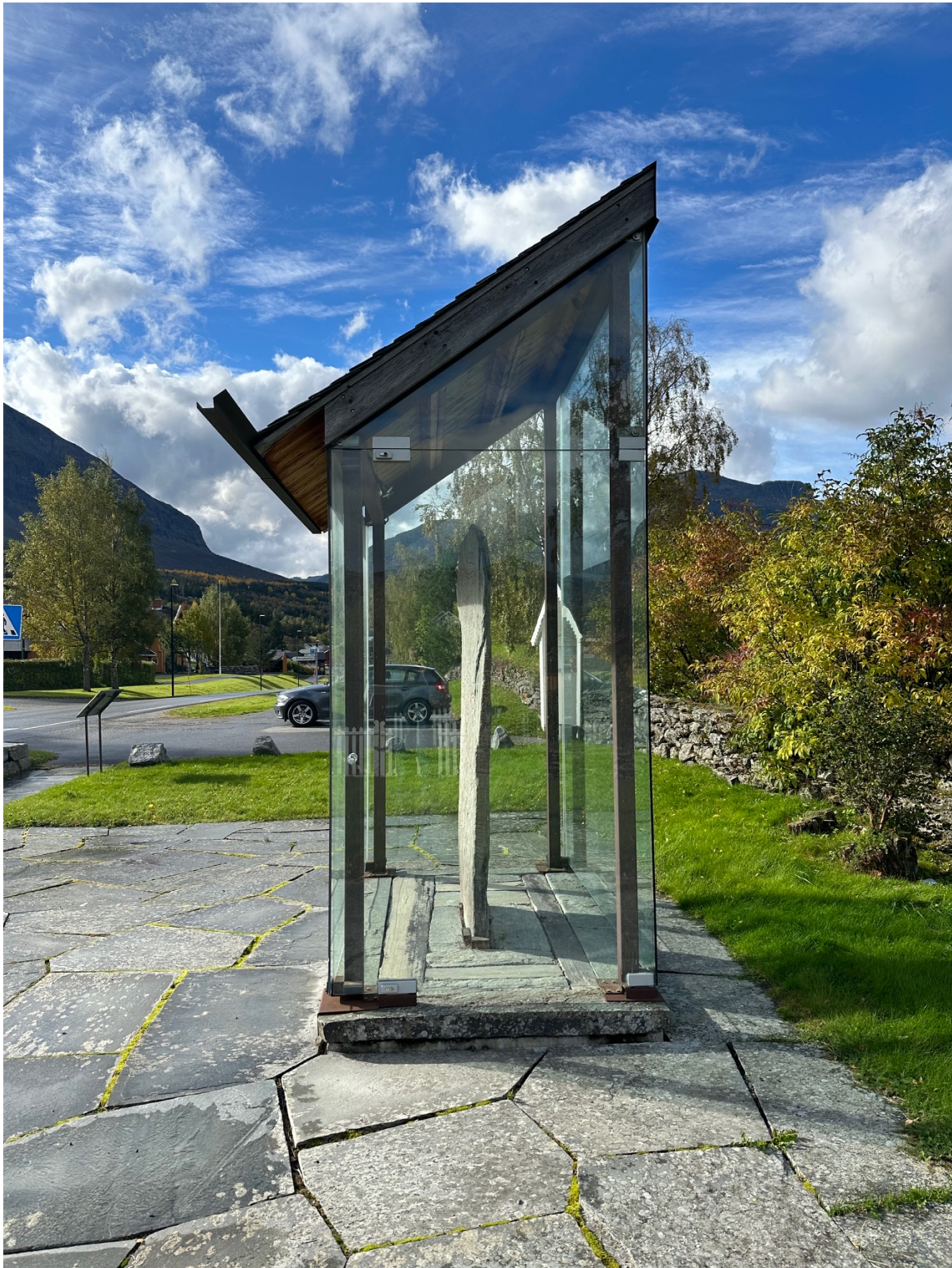
D - Foto 7: Vangsteinen, sett mot vest. Dør inn til steinen. Håndtak i glass og skjult lås
