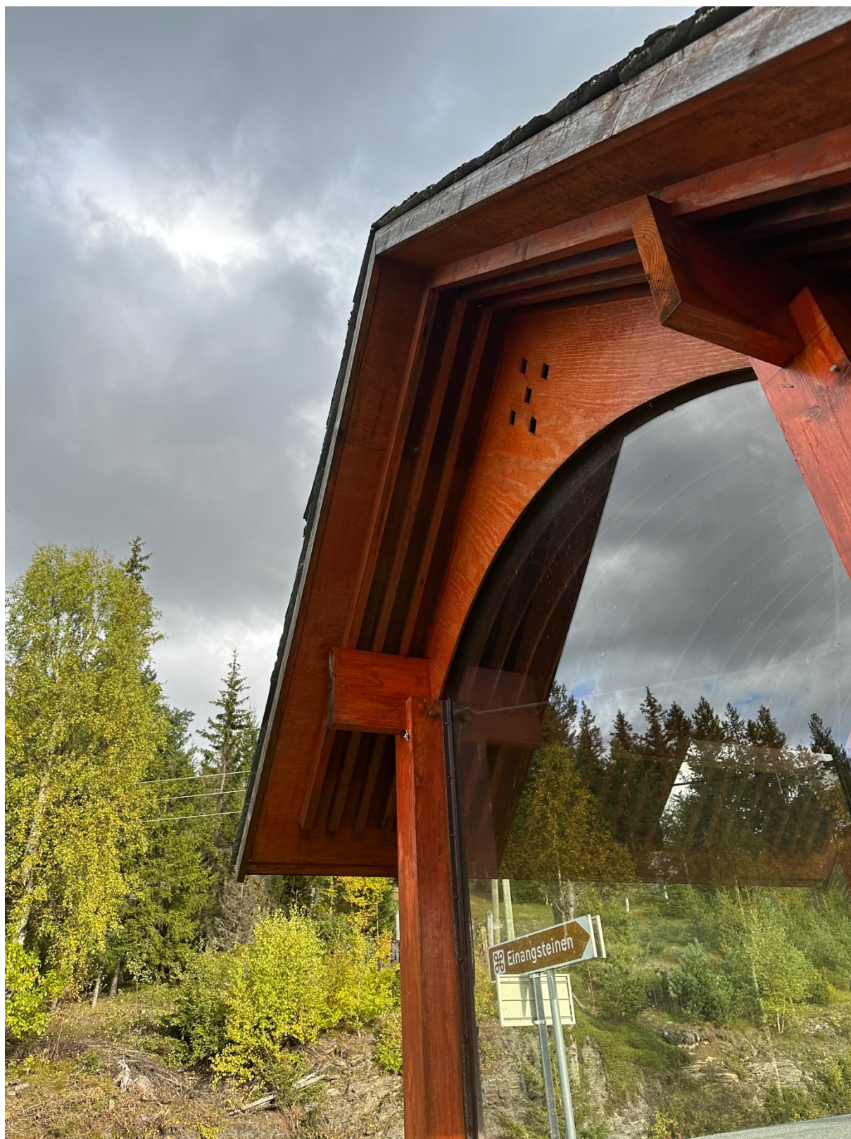
Foto 2: Einangsteinen. Detaljutsnitt takkonstruksjon. Sett fra vest.
