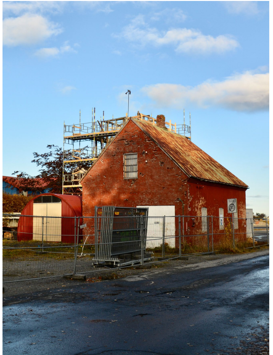
» Brannstasjonen sett fra sør.
