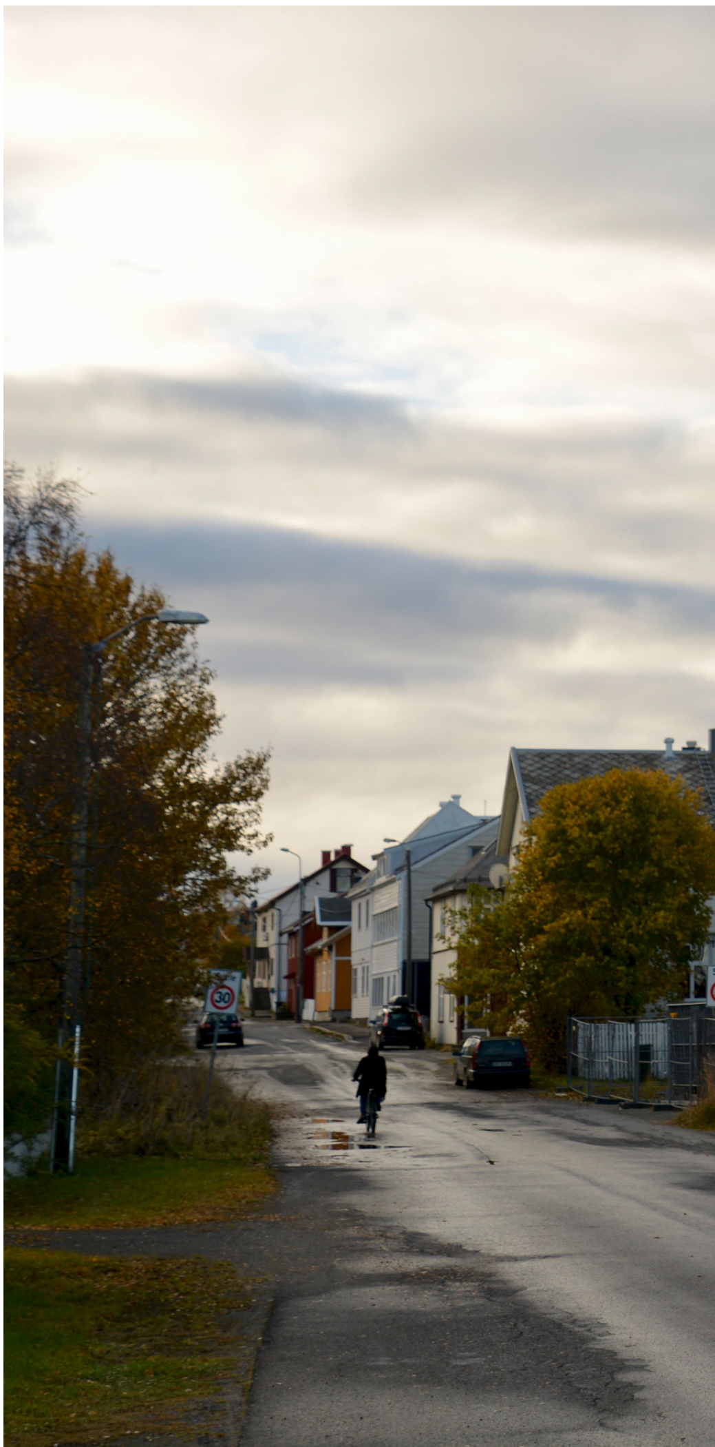
» Den røde teglbygningen i trebyen Brønnøysund. Bildet viser slangetårnet som gjennomgår reperasjonsarbeid høsten 2019.
