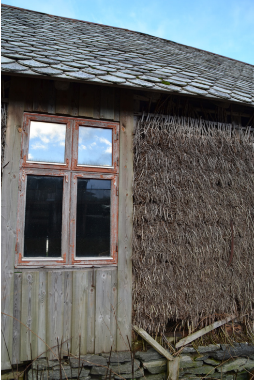
Brakevegg fremfor vinduet som gir et sjatterert lysinnslipp
