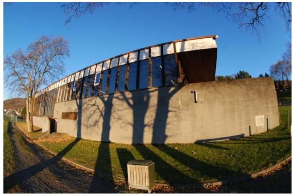
Bilde 2: Badets yttervegg mot fjorden.
