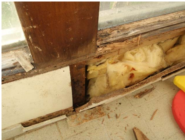
Bilde 11: Brystning under vindusfelt i svømmehall mangler membran. Det er råte i karmene.
