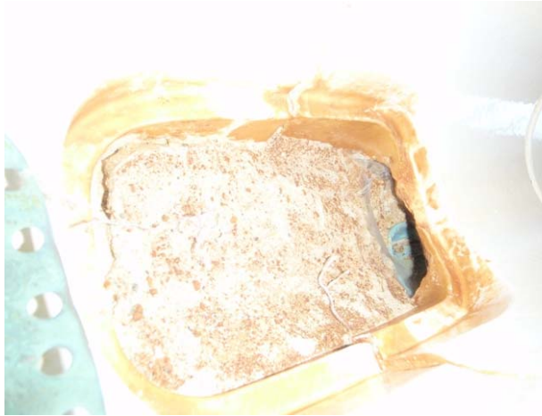
Bilde 7: Et stort flertall av utløpene fra rennene er nesten skjult under renneflisen. En feil fra byggeår.
