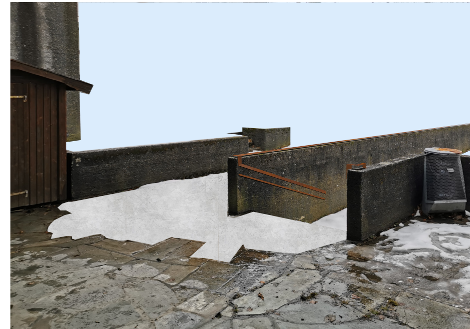
Uteområde i øst. sklisikker, lysgrå betong i møte med opprinnelig skifer.
