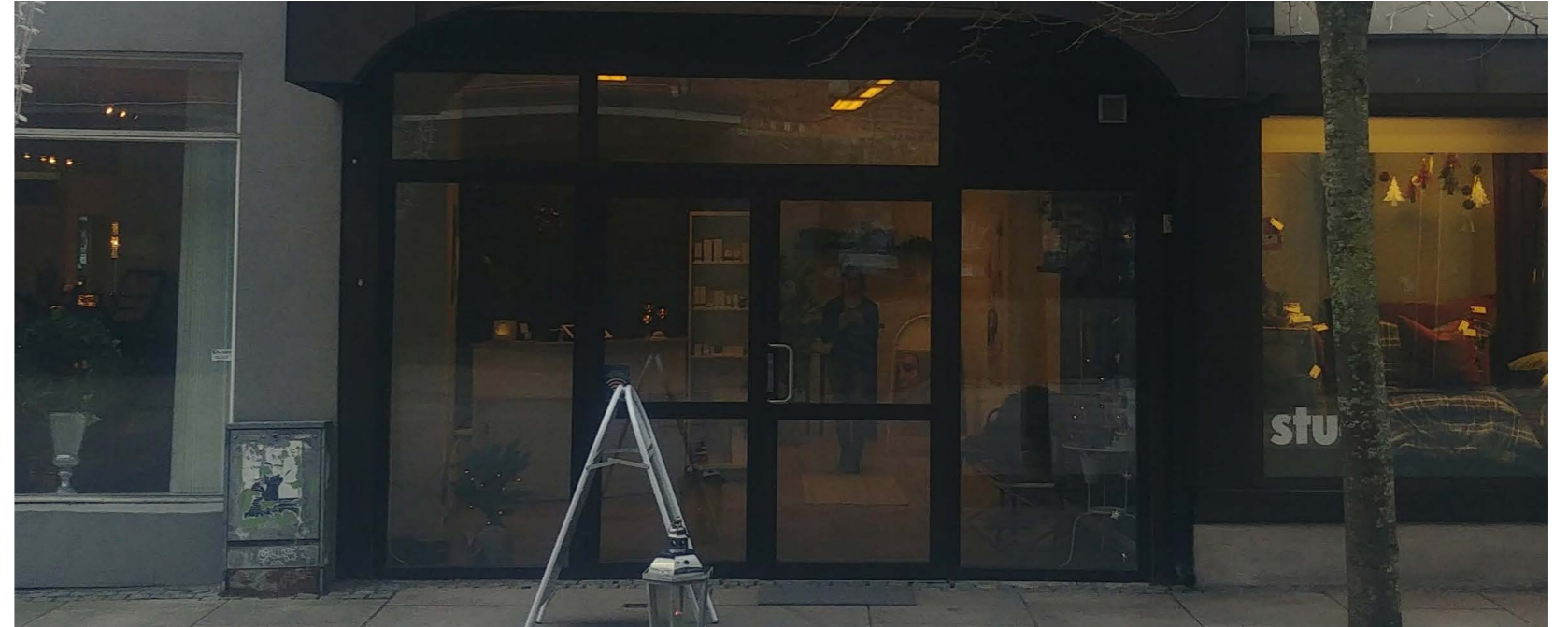
Hovedinngang og vinduer 1. etg
