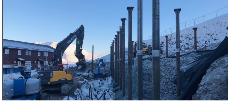
Moderne ståljernepåler. Sikrer et setningsfritt bygg. Kan drives gjennom alle typer jordlag til ønsket dybde. (Foto fra buildingsupply.no).
