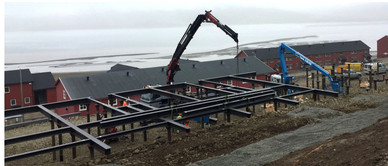
Stålrammer blir klargjort for modulbygg. (Foto fra Statsbygg).
