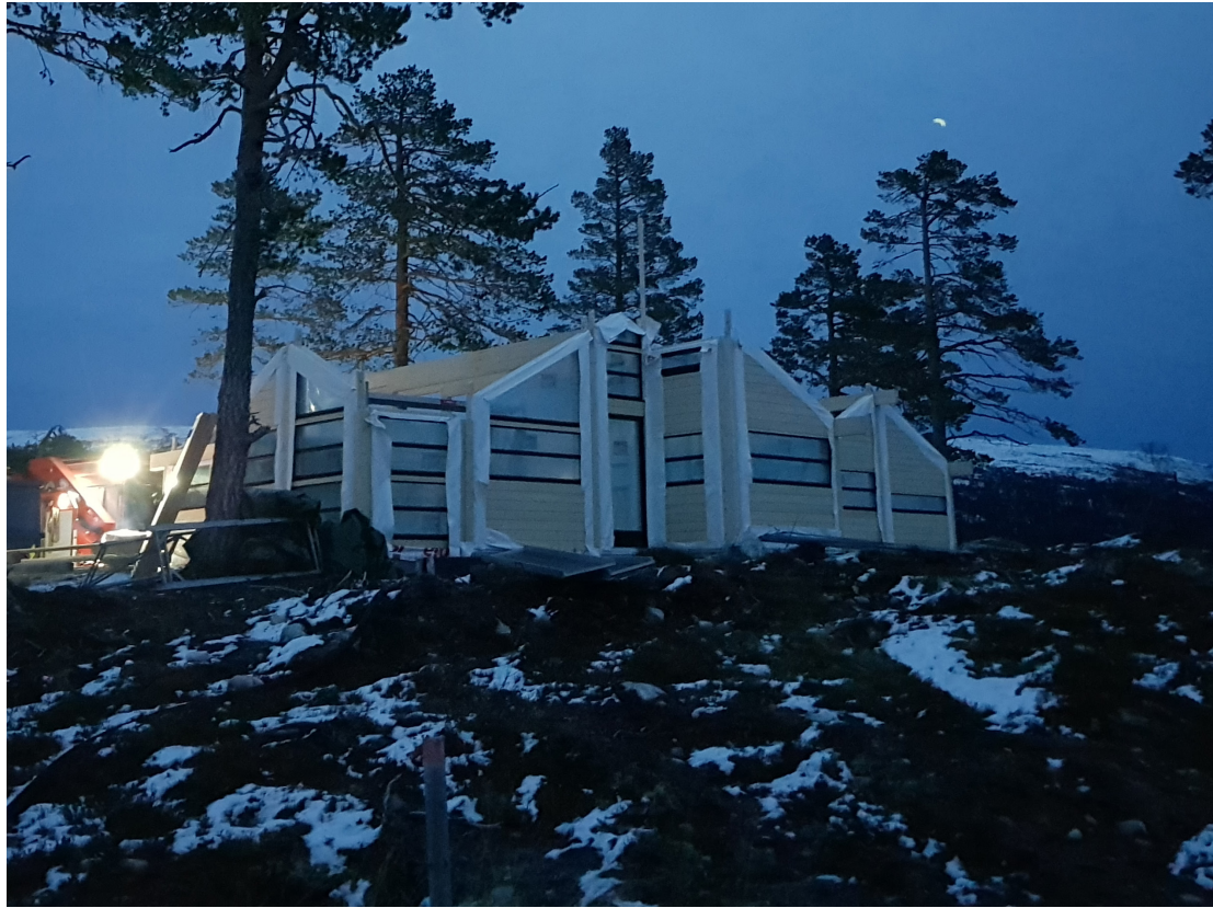
Alle modulene på plass etter en dag med kraning.
