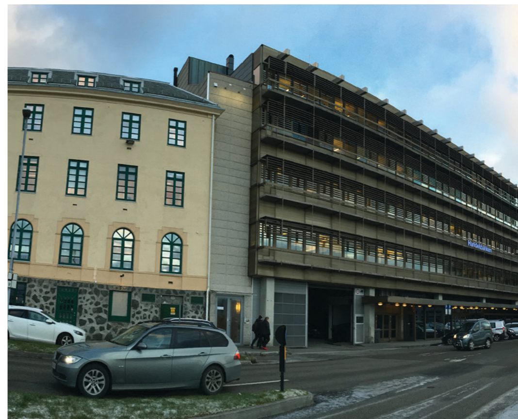
Ved vedlikehold kan man kanskje transformere fasaden med materialer og farger som passer bedre med det omkringliggende.
