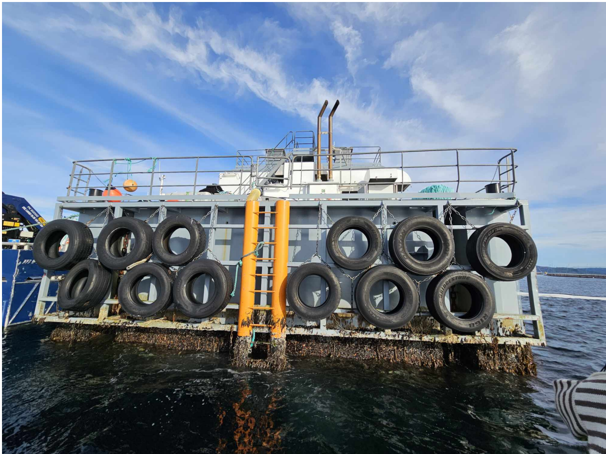
Figur 4.3: Skrog ved Lønngrunnen. Bildet ble tatt av gruppen under befaring
