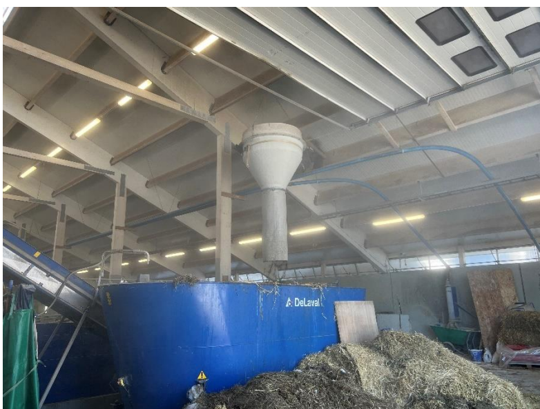
Figur 27: Fôrblender i fjøs 3. På venstre side av bildet kan man se båndet som fører fôret opp til det andre båndet som går langs hele fôrbrettet. Foto: Ellen K. B. Johansen
