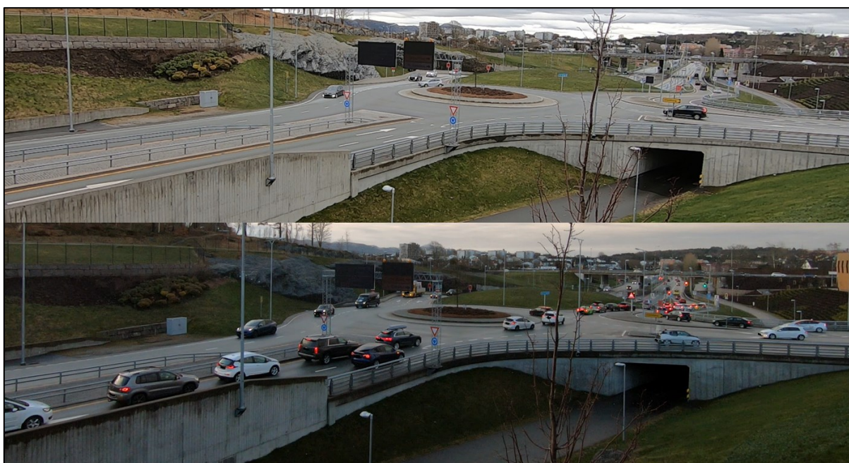
Figur 4.12: Opptak fra videokamera i rundkjøring 2, i køsituasjon og uten trafikk. Til høyre i figuren vises rampekontrollen.
