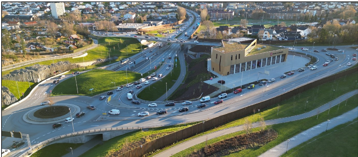
Figur 2.1: Oversiktsbilde over påkjøringsrampen. Foto: Arvid Aakre.
