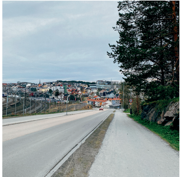
Figur 51: Frydenlundsgata fra nordlig ende (Sagfjord, 2023)
