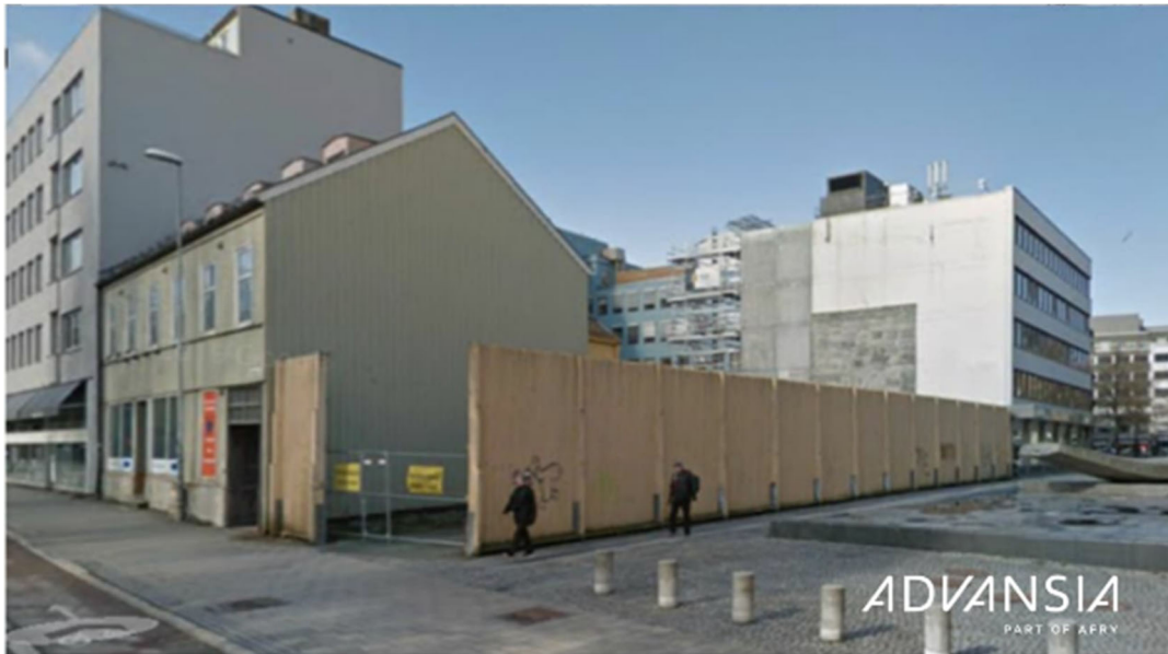
Bilde 7: Kjøpmannsgata 36/38 før bygging og rehabilitering. (Kilde: Advansia)
