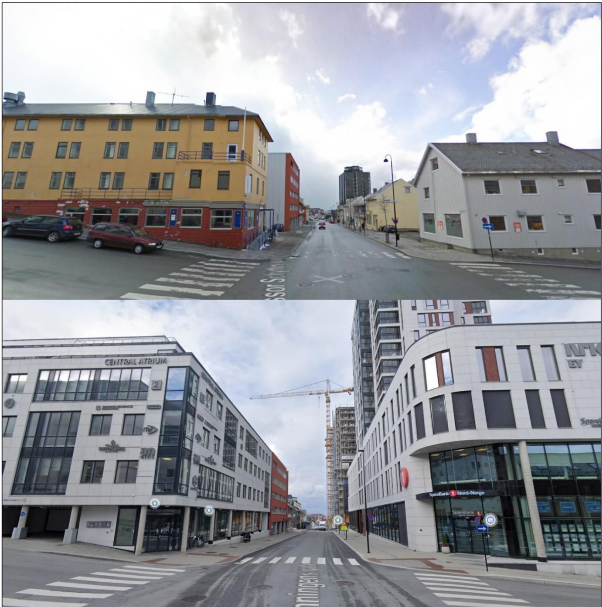
Figur 32. Bildene er av samme gatekryss med ti års forskjell 2012-2022. Grensen til NB!-området går langs nærmeste tverrgate og det sees over på byggene som ligger helt opptil gjenreisningsbyen og som har erstattet bygg i gjenreisningsstil (Google maps, 2010; Google maps, 2022c)
