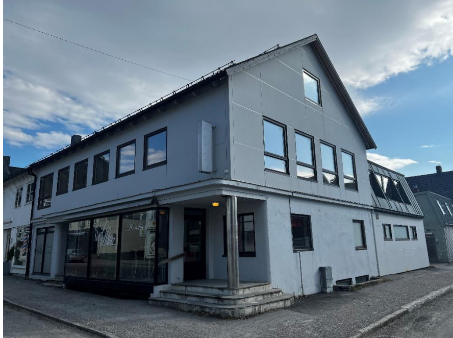
Eksempel på platelagt bygg. Foto: Tor-Einar Siebke
