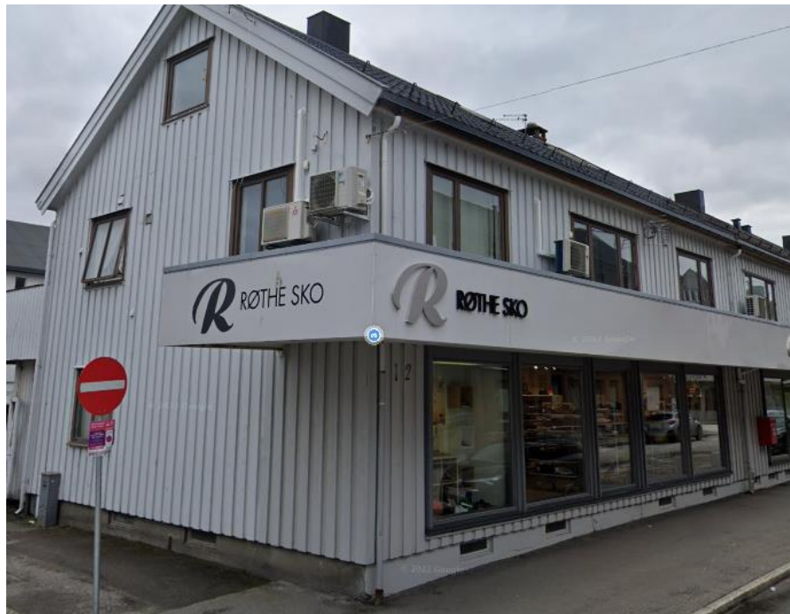
Godt synlige varmpumper og andre tekniske installasjoner. Foto Google maps
