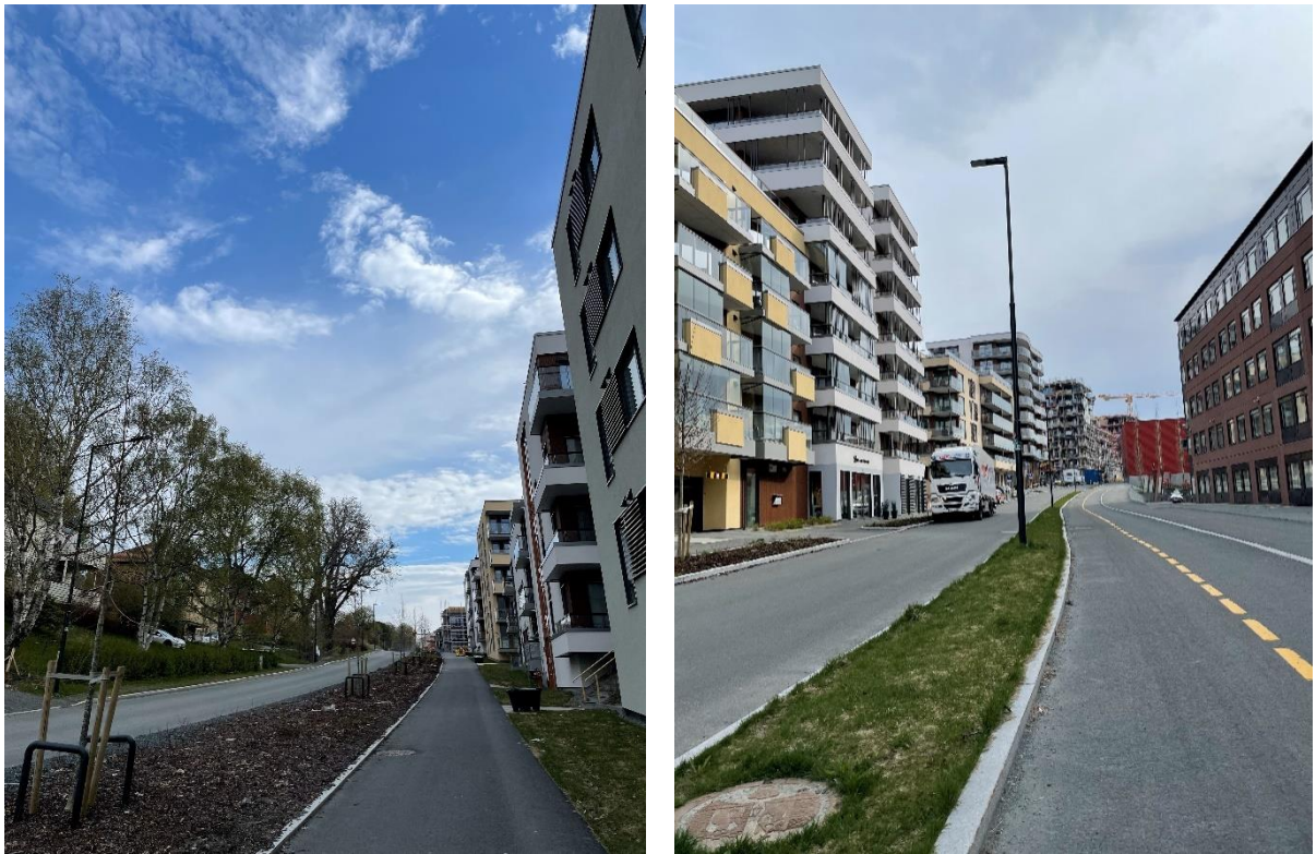
Figur 26. Bredt gatetverrsnitt med ulike kvaliteter både i Lade allé (t.v.) og Ladebekken (t.h.). Til høyre i Ladebekken vises opparbeidet gang- og sykkelveg.
