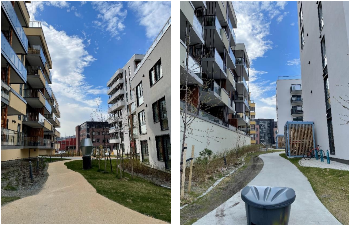
Figur 39. Flere siktlinjer gjennom bebyggelse via adkomst fra Lade allé.
