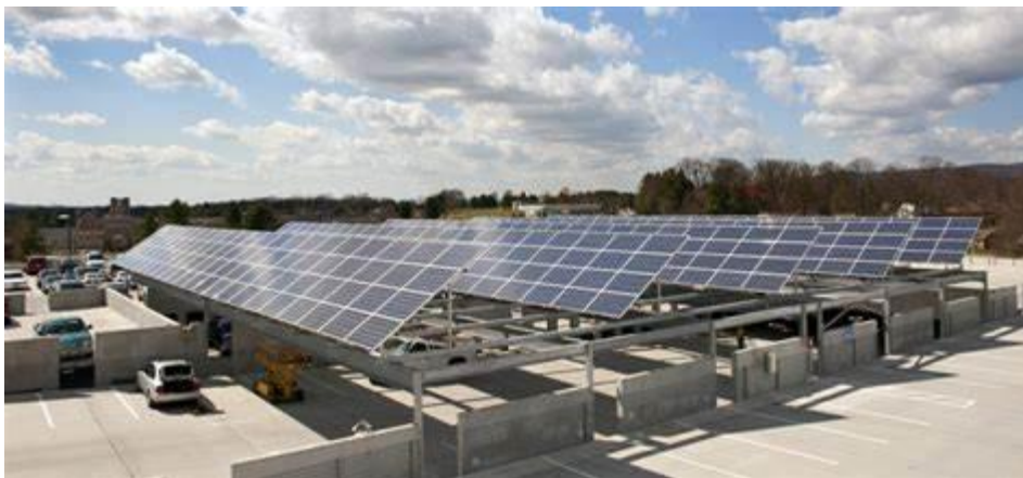
Figur 4.4 - Eksempel på "Parking lot PV". Kilde: wileywilson.com, 2023.
