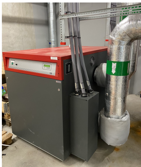
Figur 14: Bilde av en av de to elektrokjelene i Billingstad Energisentral.
