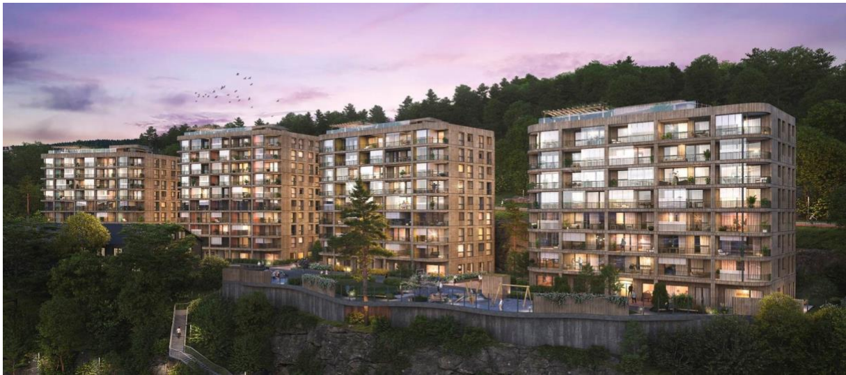
Figur 4: Prosjektet består av fire bygg, hvorav enkelte enheter er utviklet med delemeter, mens andre fremstår som tradisjonelle leiligheter (AF Gruppen, u.å.).
