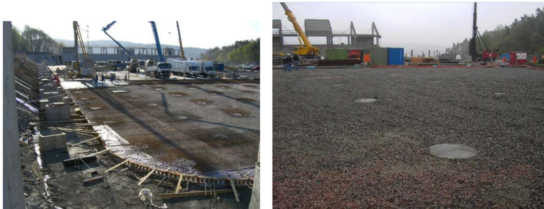
Figur 2.3.8: Sør arena i Kristiansand under bygging [1].
