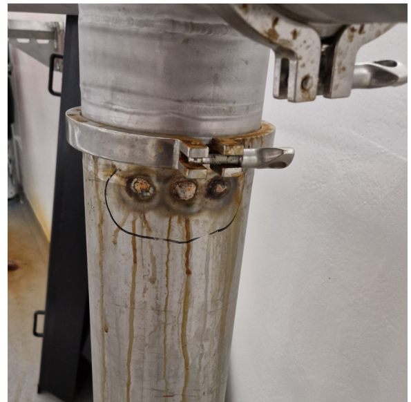
(d) Pitting repairs at InnovaNor
