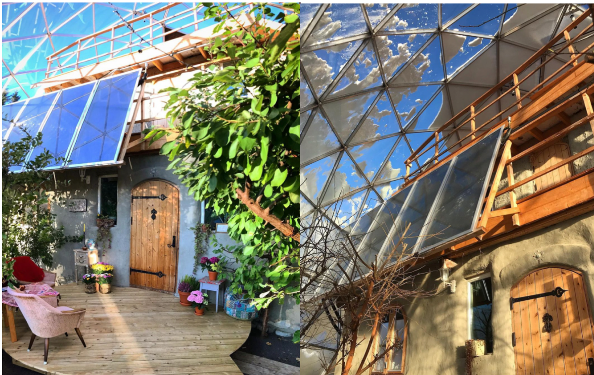
Figur 13. Solfangere inne i glassdomen. Foto: Alise.
