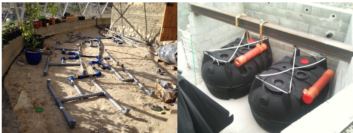
Figur 14. Kretsløp og fermenteringstanker i naturhuset.. Foto: Atlas.
