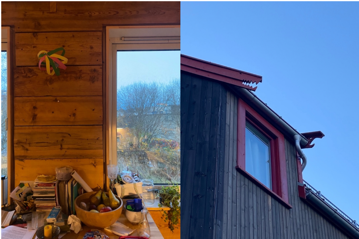
Figur 26. Gjenbrukte vinduer og treverk. Foto: Ann Mathea.
