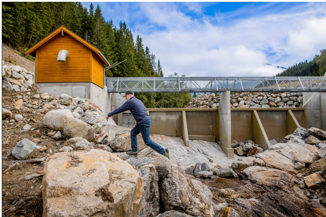
Figur 2.5: Dammen sett fra fra nedstrømssiden. [27]
