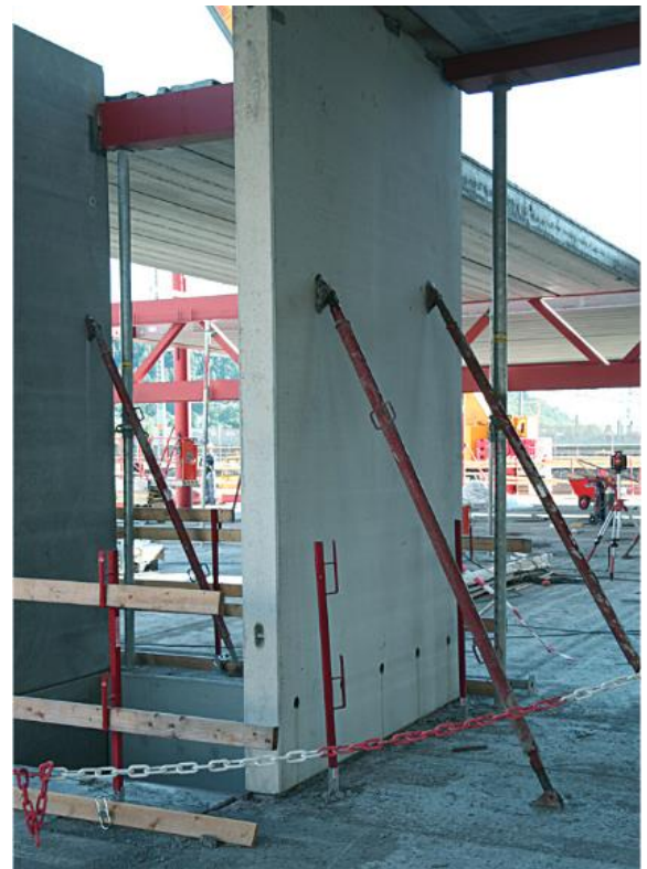
Figur 15 Staging av veggelement (Betongelementforeningen 2020b, s. 67)
